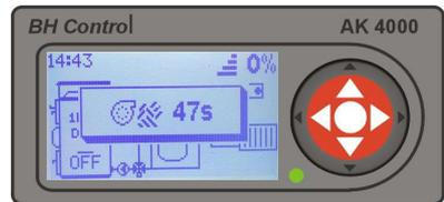
Premendo il tasto "ENTER" viene visualizzato il pulsante rotondo. Premendo il pulsante ◀ la caldaia si spegne. Dopo lo spegnimento, la ventola è accesa. Durante i 60 secondi il bruciatore del pellet viene raffreddato. Premendo ☑, il pulsante rotondo scompare.
