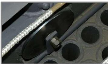
Quando si pulisce lo scambiatore a tubi (fig.3/24) accertarsi che l'area del deflettore sia pulita, così come il flap stesso. (fig. 3/16). La perdita può ridurre le prestazioni della caldaia.
